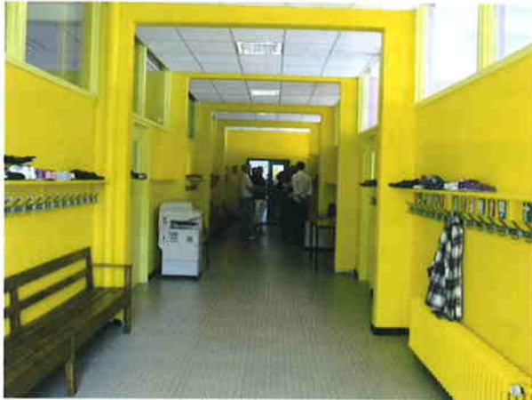
Travaux de peinture, couloir de l'école
