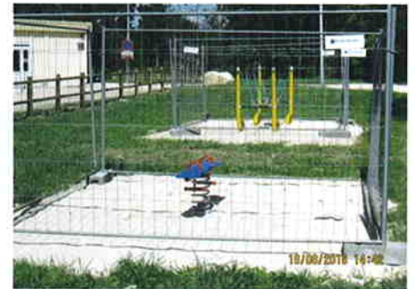
Construction aire de jeux Fourouze
